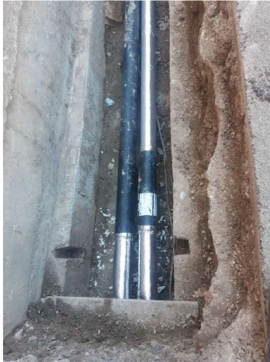
Photo du réseau ECS après réparation de la fuite au B5
